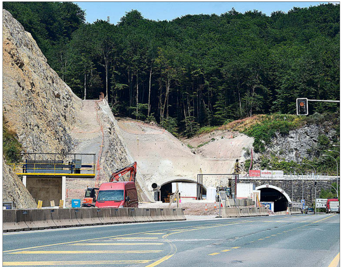
Imagen de las obras en los túneles de Belate adjudicadas a Acciona, Osés y Servinabar. DANIEL PÉREZ / EFE
