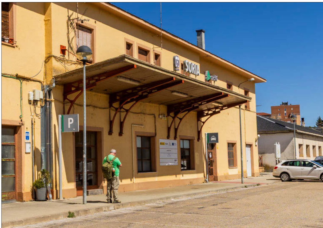
Fachada principal de la estación de Soria. MARIO TEJEDOR
